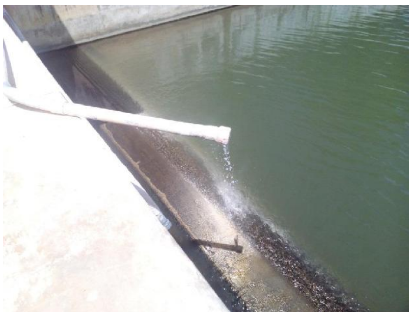
Figura 2-26. Dosificación de sulfato de aluminio y cal.
