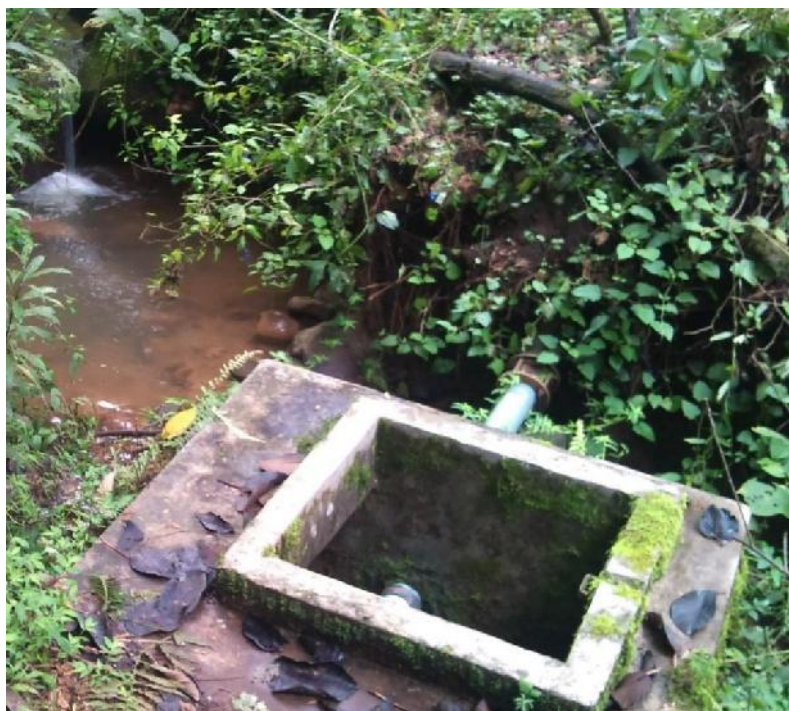
Figura 2-20. Válvula de desagüe (desprotegida)
