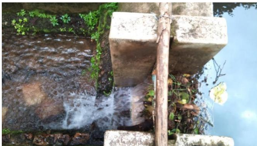
Figura 2-17. Rejilla de salida de excesos.
