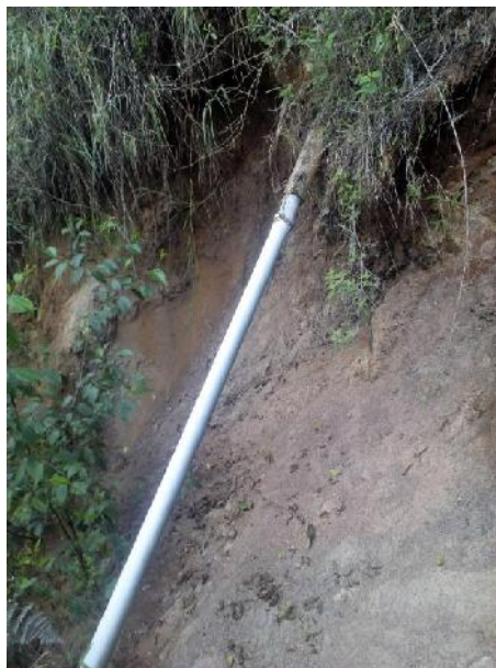
Figura 2-22. Tubería a nivel de terreno (Deslizamiento)
