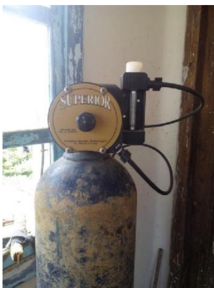
Figura 2-28. Cilindro de cloro gas para desinfección.
