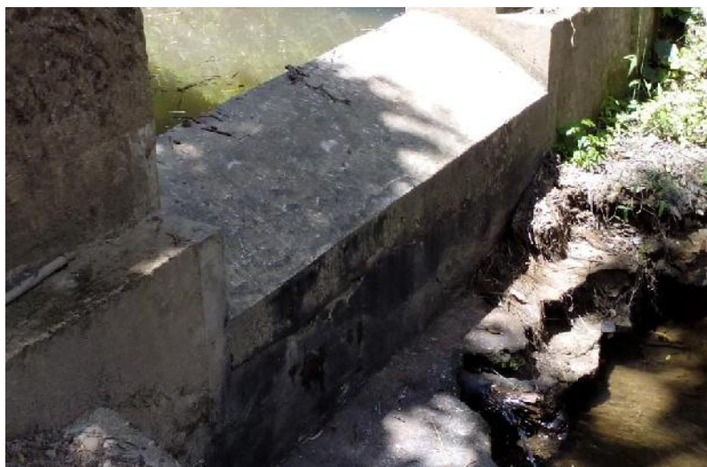
Figura 2-12. Presencia de socavación en el muro transversal.
