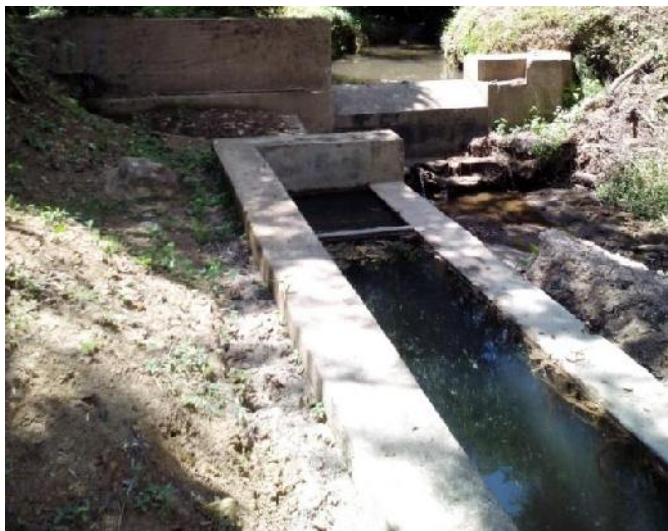
Figura 2-10. Estructura de desarenación.
