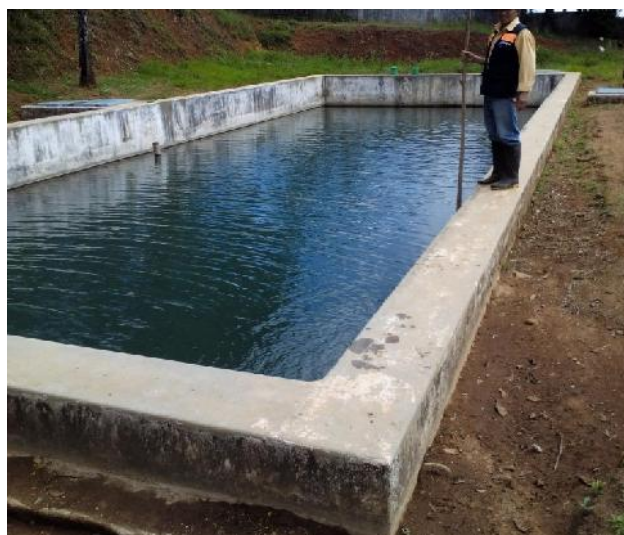
Figura 2-24. Sedimentador de flujo horizontal.
