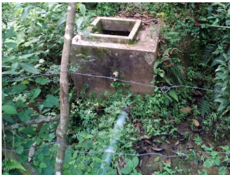
Figura 2-21. Tanque rompe presión (deteriorado)
