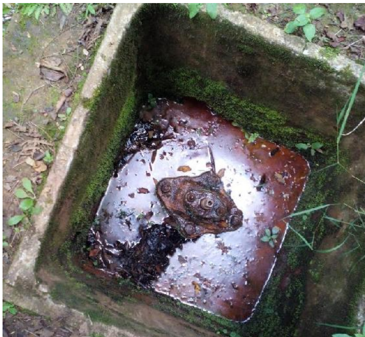
Figura 2-19. Válvula de aire (inundada)
