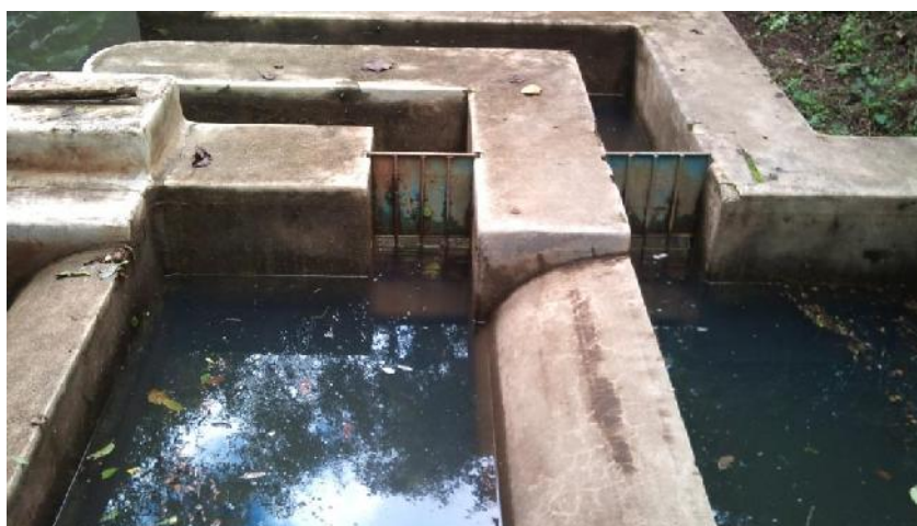
Figura 2-15. Recolección de agua con placas metálicas perforadas.
