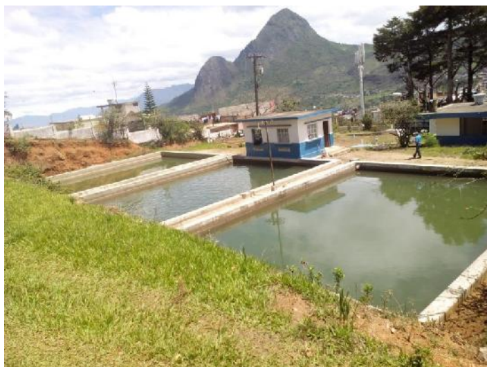
Figura 2-27. Sistema de filtración lenta en arena.
