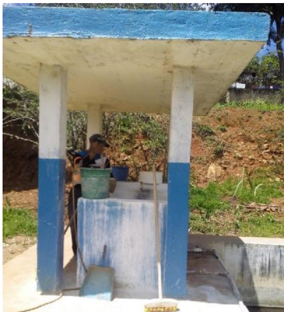
Figura 2-25. Estructura para dosificación de sulfato de aluminio y cal.
