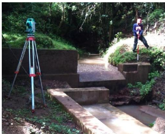
Figura 2-9. Muro transversal de captación.
