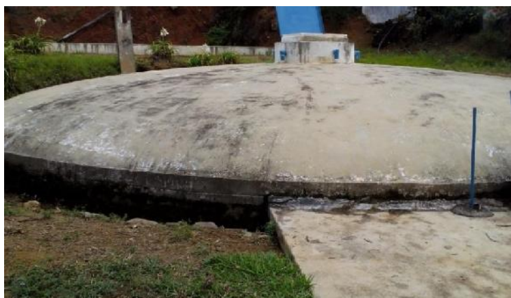
Figura 2-29. Tanque de reserva V=250 m 3
